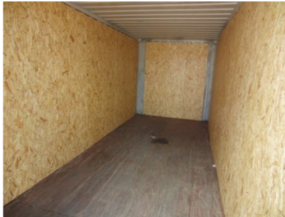
Figura 7.53 Revestimiento de un contenedor de 40 pies con paneles de cartón usado
