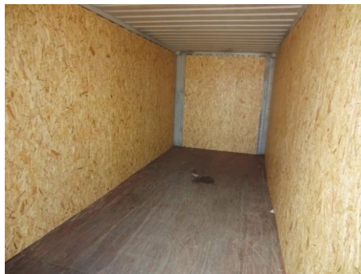
Figura 7.53 Revestimento de um contêiner de 40 pés com painéis de aglomerado
