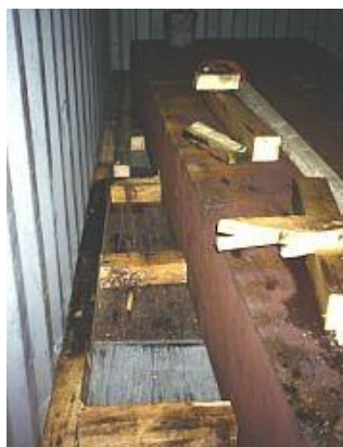
Figura 7.45 Travamento transversal da placa de aço
